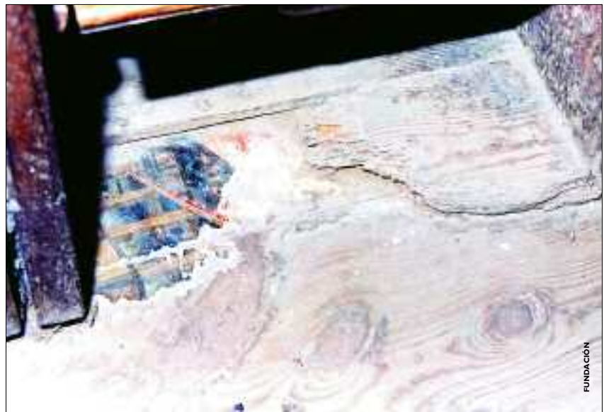
Restos de pintura de las tablas del retablo visibles bajo los sitiales del coro.
